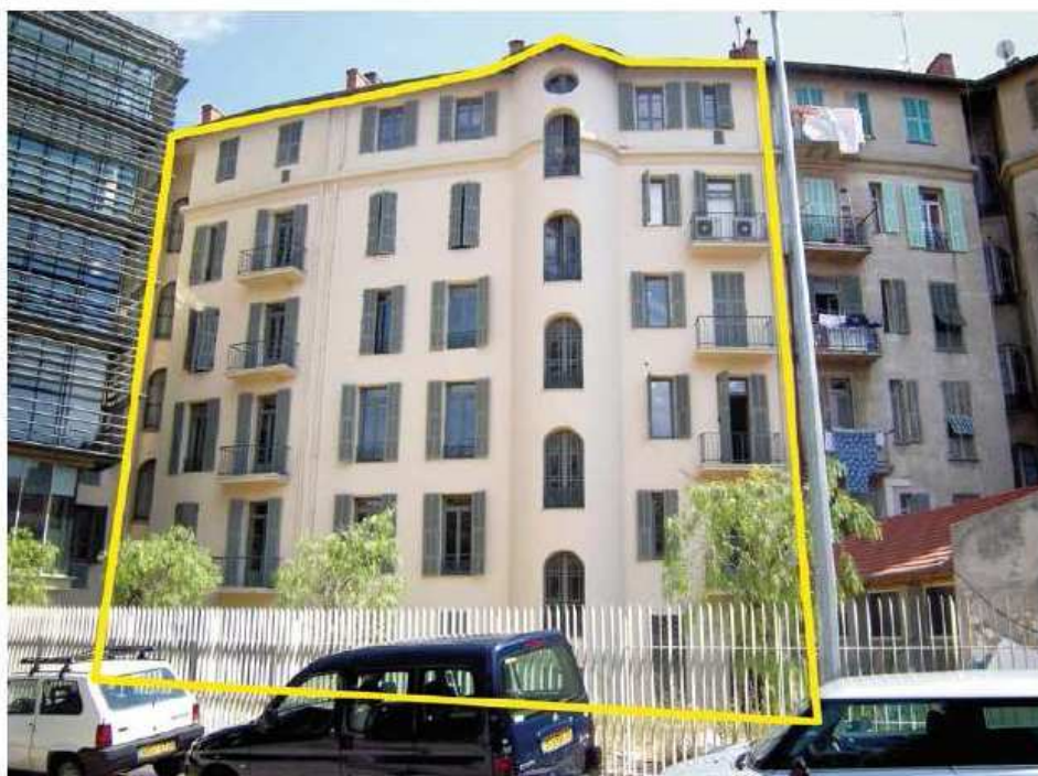
Façade NORD – Rue Theuriet
