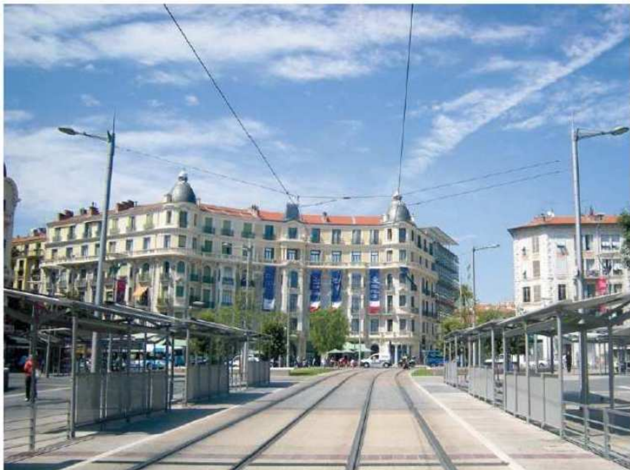
Façade Sud – Place Général de Gaulle
