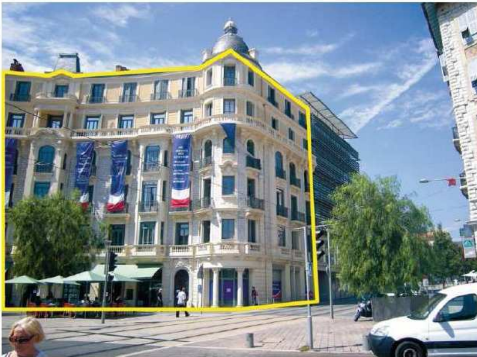
Façade SUD – Place Général de Gaulle
